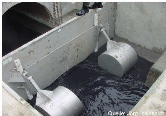
Rys.2. Hamulec przepływu HYDROSTYX®
