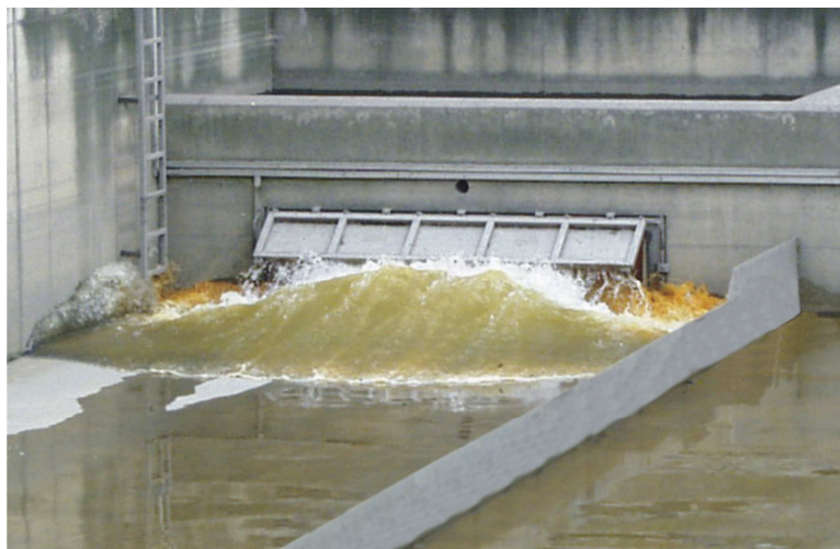
Rys. 6. HYDROSELF® - spiętrzona fala płucząca w zbiorniku prostokątnym
