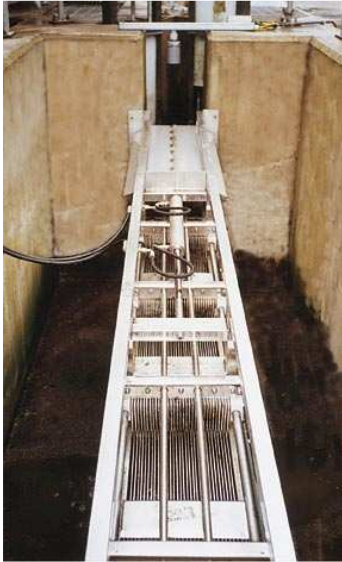
Rys. 9. Krata HYDROSCREEN® w pozycji poziomej Rys. 10. Krata HYDROSCREEN® w pozycji pionowej
