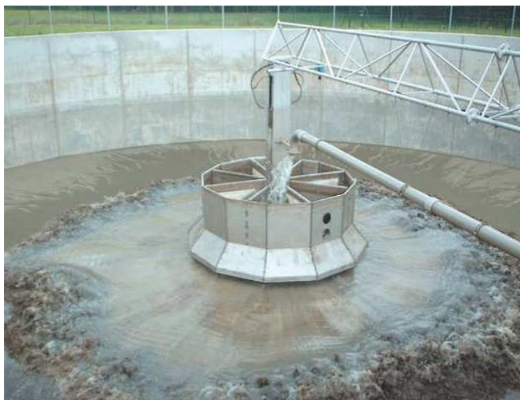
Rys. 7. HYDROSELF® - spiętrzona fala płuczcząca w zbiorniku okrągłym
